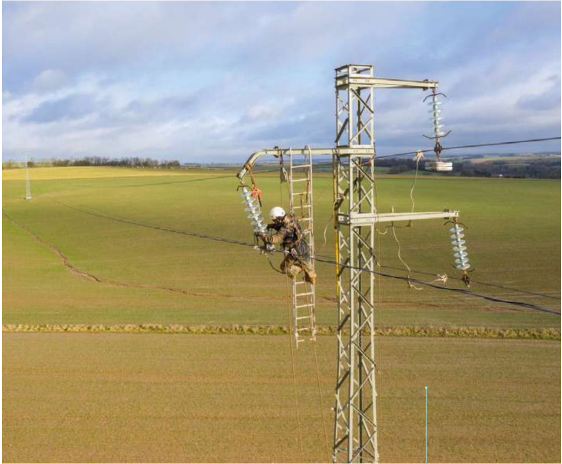
Changement des Isolateurs dans le Pas-de-Calais (62)
