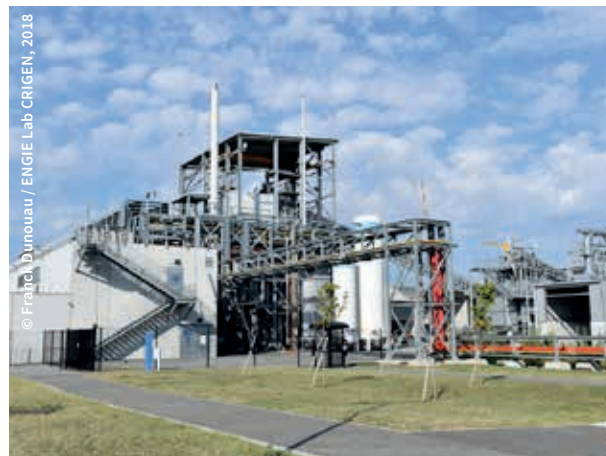
Plateforme du projet Gaya
