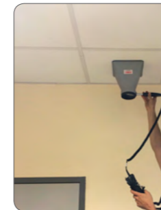
Mesure de ventilation
