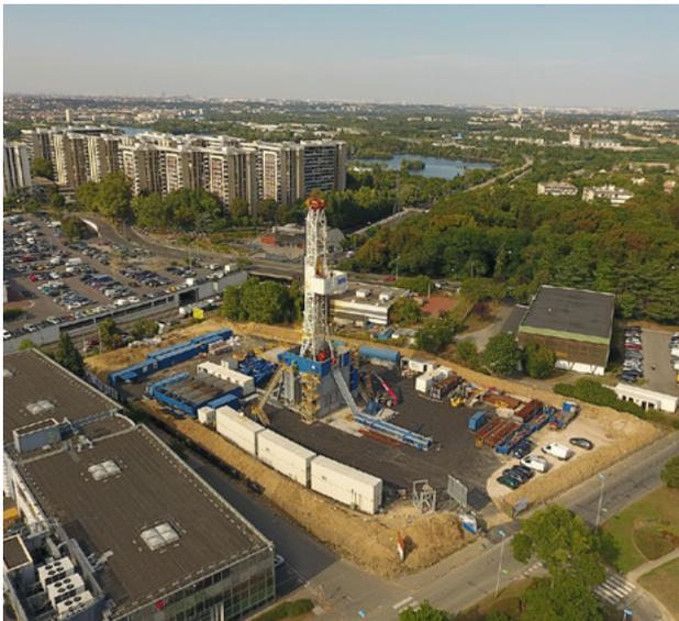
En 2017, la centrale de géothermie profonde de Grigny voit le jour et se raccorde au réseau de chaleur urbain des villes de Grigny et de Viry-Châtillon. La centrale exploite l'aquifère du Dogger grâce à un doublet de forage à 1 600 m de profondeur et alimente ainsi 10 000 logements et plusieurs bâtiments publics.
