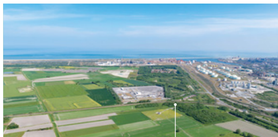
Vue aérienne de la zone d'étude à terre pour le raccordement du parc éolien en mer de Dunkerque (59)
