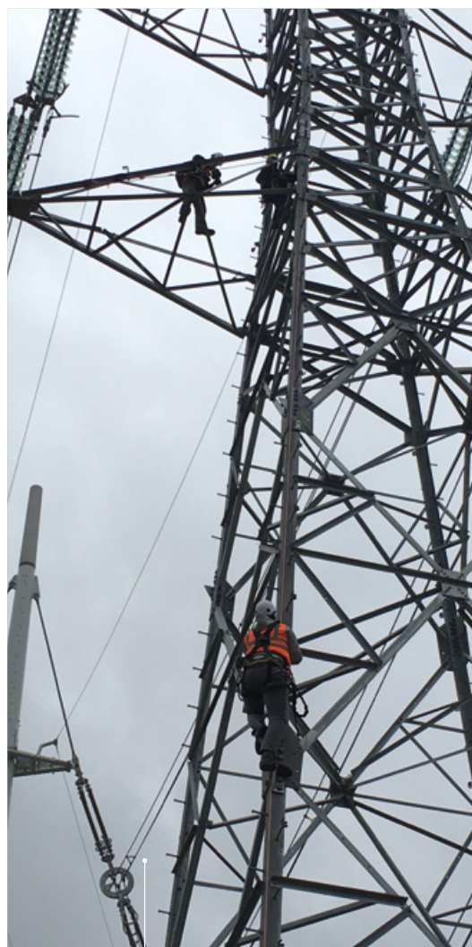
Essai d'ascension d'un pylône pour des candidats à l'insertion professionnelle à La Capelle (02)
