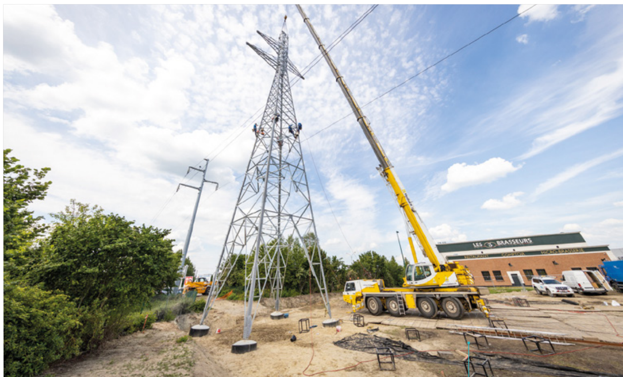
Chantier à Petite-Forêt (59)
