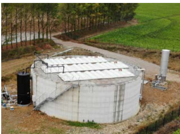
La chaudière biogaz de la sucrerie de Cristal Union à Fontaine-le-Dun
