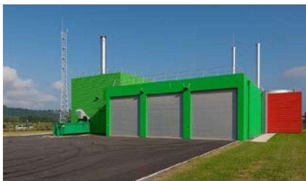
Chaudière bois de Safran Helicopters Engines à Bordes (64)
